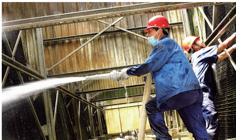
近期,最高气温达到了36℃,氨纶公司迅速组织相关人员,利用一天时间紧急清洗八期冷却塔,将附着在填料上藻状和絮状物及塔底淤泥等彻底清理干净,从而保证冷却塔通风量,使八期动力设备得以在高温环境下安全运行,接受高温“考验”。(氨纶宣)
